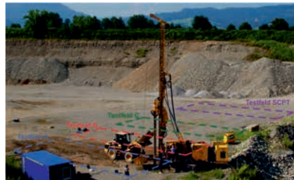
Abbildung 1: Tiefenrüttler während der Verdichtungsversuche auf dem Versuchsfeld in Fischen
